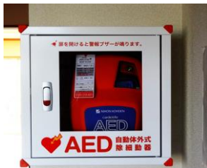
公民館上がり口右側に設置
